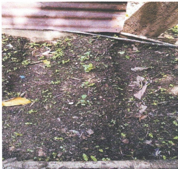
IMAGEN 2. Falta de desmalezado
