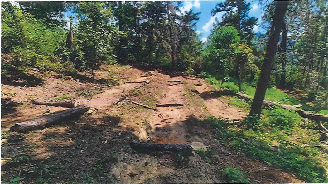
Fotografía 4. Construcción de terrazas como prácticas de conservación del suelo y agua
