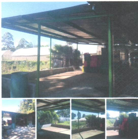
Figura 1. Modificación de la parte externa del área de empaque de hortalizas.
