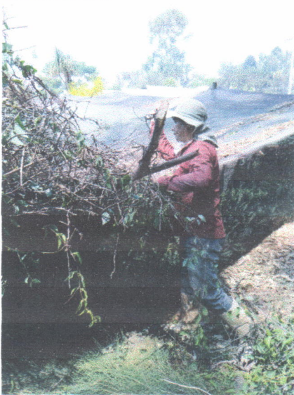
Imagen 11. Limpieza y evaluación de sarán en el área del cobertor.
