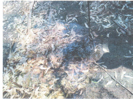
Imagen 10. Fuga de agua por tuberías rotas.
