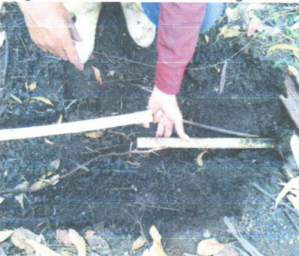
Imagen 9. Revisión de tubería de riego.
