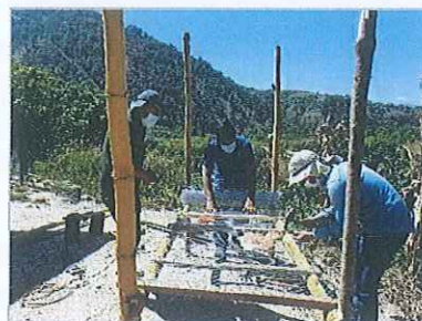
Figura 8 Construcción de conejera en Los Mangales
