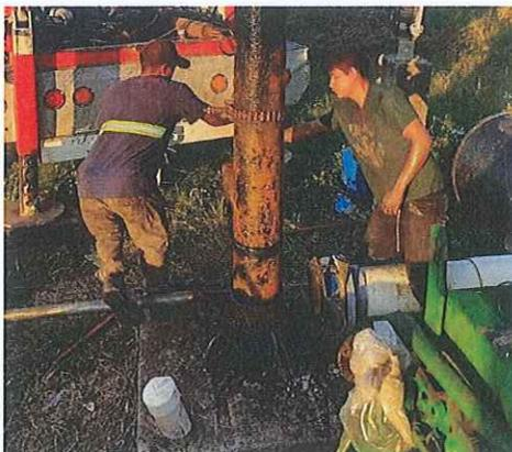
**Anexo 11** Utilización de grúa para la extracción de la tubería.
