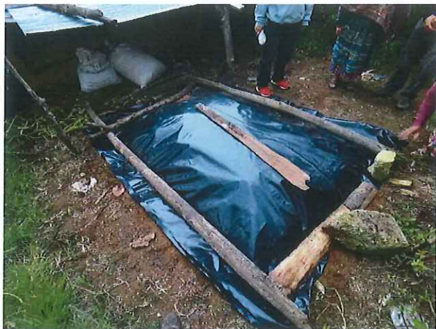
Abonera tipo “Bocashi” terminada
