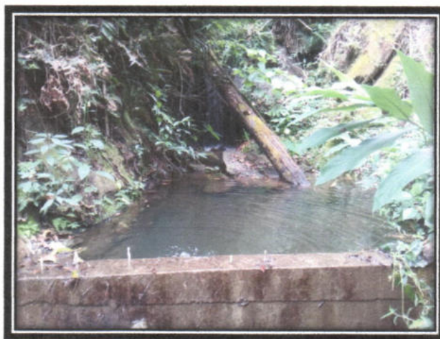
Figura 7. Tanque de captación de agua en riachuelo "El Castellano" Fuente: Propia.
