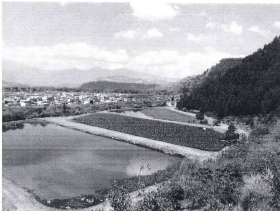
Fotografía 4. Planta de tratamiento la Cerra, administrada por AMSA, Villa Canales.
