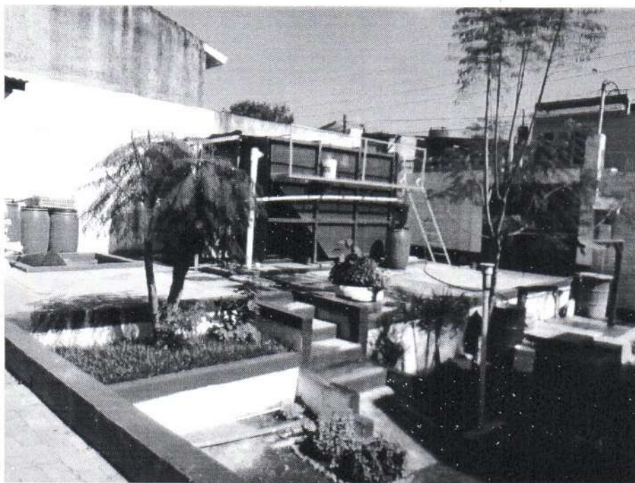
Fotografía 3. Planta de tratamiento de la colonia San Luis, Villa Nueva.
