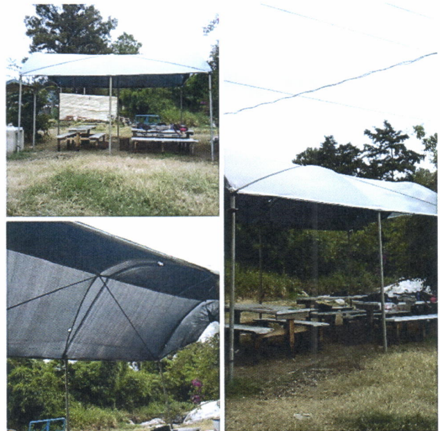
Figura 2. Modificación del techo ubicado en el comedor de hortalizas para estudiantes y trabajadores.
