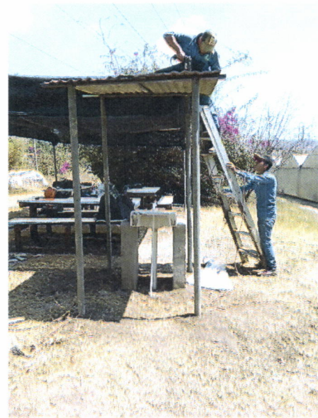
Figura 2. Instalación de techo al lavamanos que se encuentra en el comedor de hortalizas como parte de las Buenas Practicas de Agricultura.
