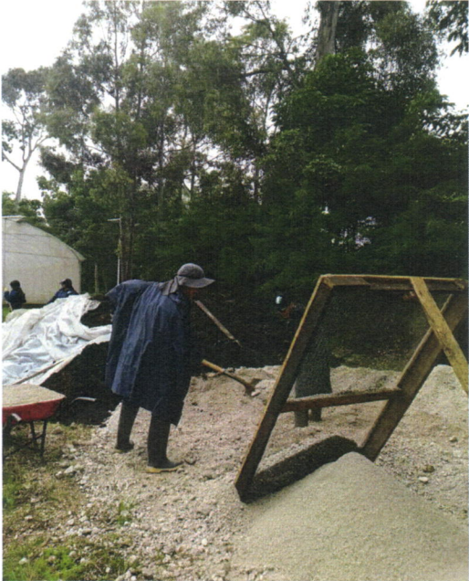
Figura 1. Cernido de tierra y arena, y mezcla de las mismas con bovinaza.
