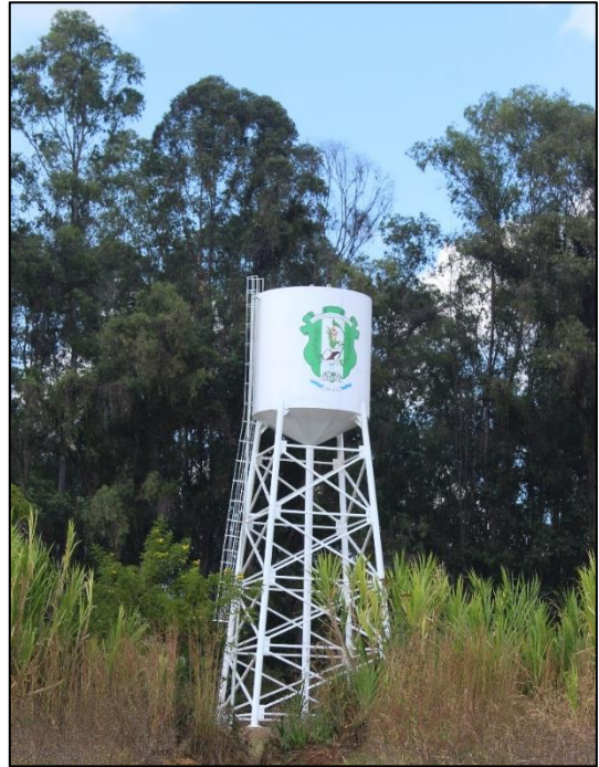
Foto: Nuevo Tanque elevado.
