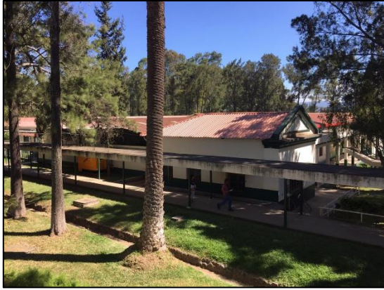
Foto: Edificio Central con techo nuevo.
