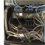
Imagen #21: Patch Panel Siemon con 20 puertos usados.
