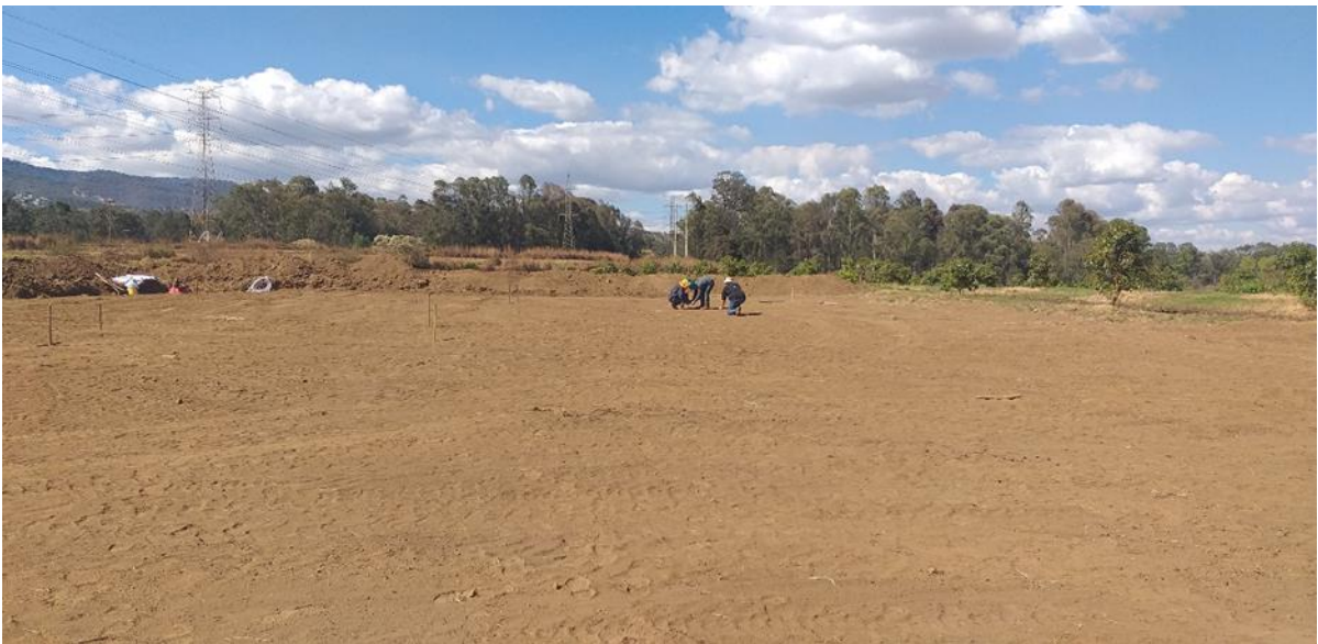
Fotografía No. 3: Nivelación y construcción de Invernaderos.
