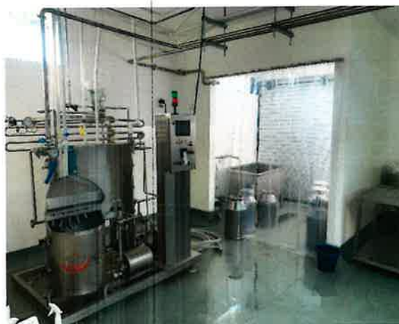
Figura 2: Supervisión de maquinaria
