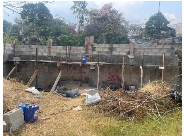
Instalación de ventiladores en el área del rastro, así como levantado de hiladas de block en muro colindante a la Aldea Bárcenas.
