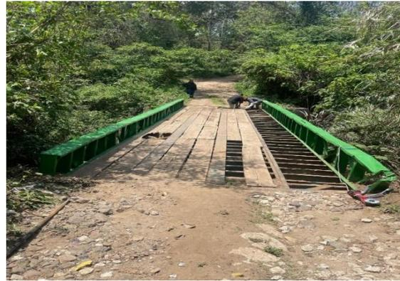
Se realizó mantenimiento preventivo y correctivo al puente que se encuentra sobre el río platanitos (interno), en la cual se cambiaron tablonces de madera, cambio de piezas dañadas y aplicación de pintura anticorrosiva.
