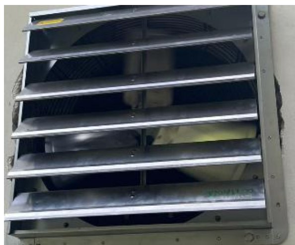
Descripción: Izquierda, instalación de cortinas de aire en el área del comedor. Derecha, instalación de ventilador axial área de la panadería.
