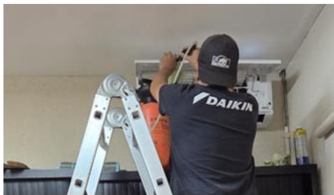
Descripción: Proceso de mantenimiento al aire acondicionado.
