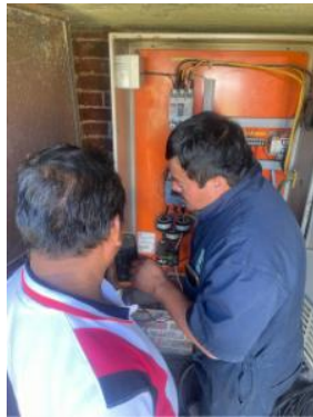
Imágenes 18, 19 y 20: Se brindó mantenimiento preventivo a los tableros y controles de los paneles que contemplan
