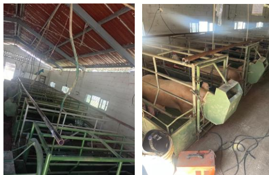
Imágenes 19 y 20: Se atendieron reparaciones diversas a las jaulas que se encuentran en la granja de cerdos de la ENCA.
