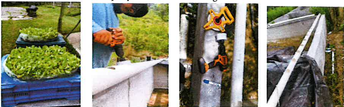
Figura 1. Instalación de tubería pvc para el cultivo de lechuga.
