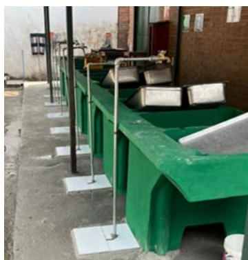
Imagen 3: Remozamiento de área de pilas de cocina.
