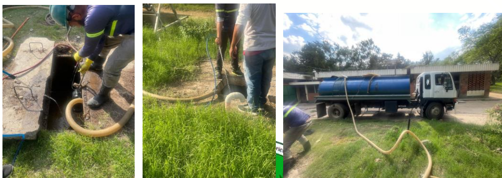
Imágenes 21. 22 y 23: Se brindó mantenimiento preventivo y limpieza a la fosa séptica y cajas del drenaje sanitario del área de cocina.
