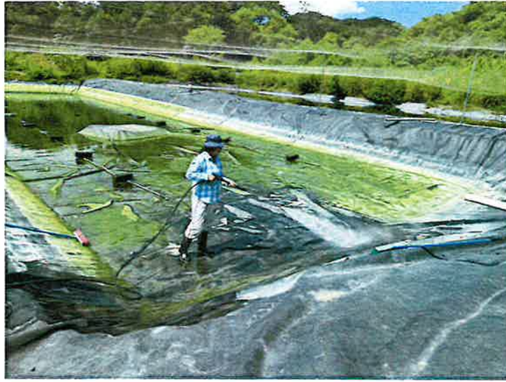
Figura 6. Limpieza de estanque.
